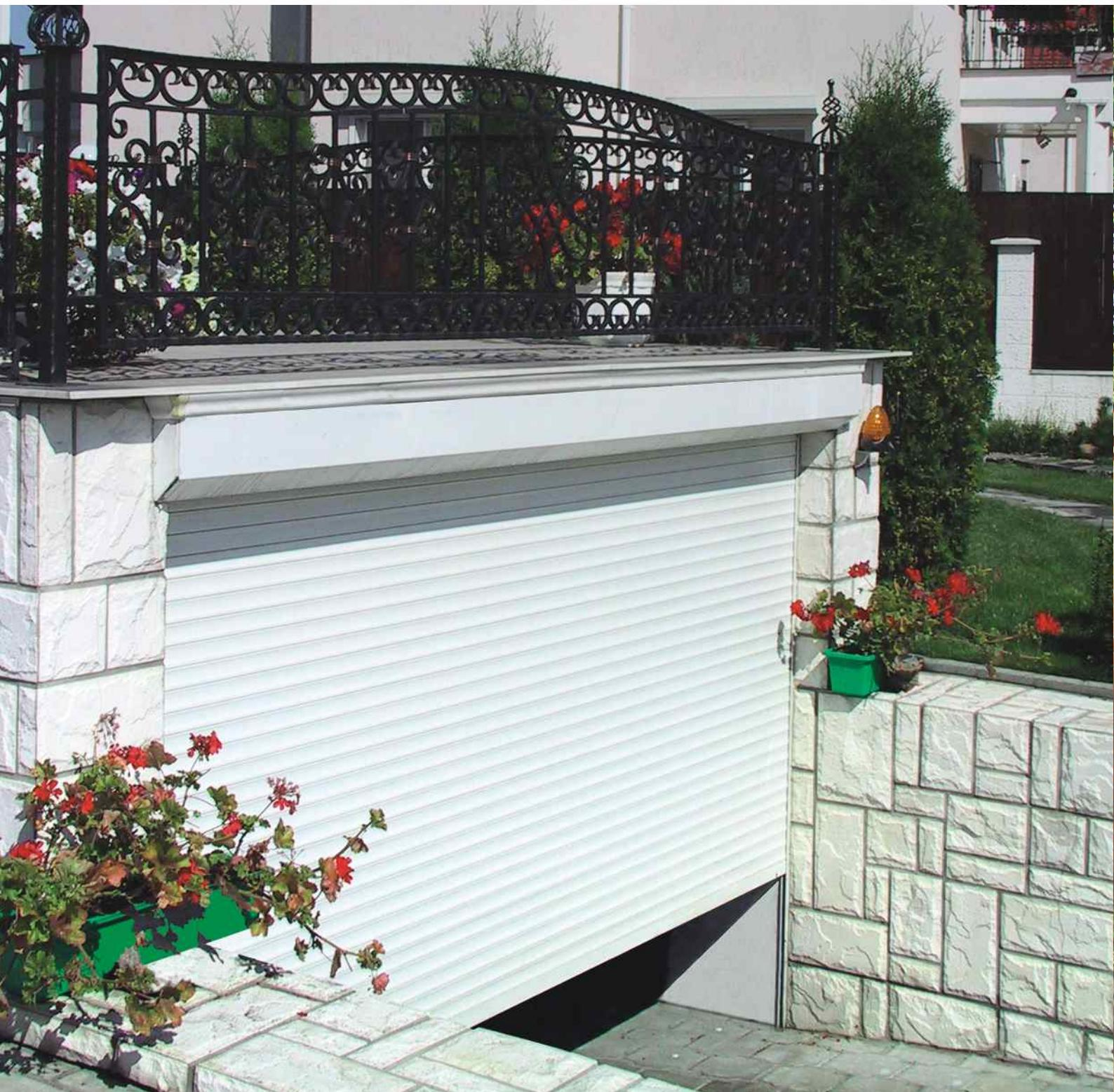
Монтаж с защитным коробом серии SB45
